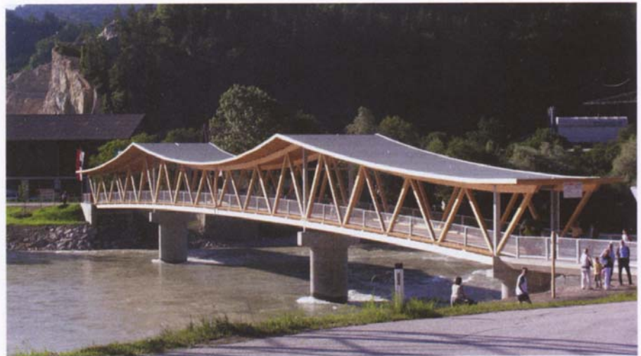
Als kostengünstig und innovativ gepriesen: Neue Notburgabrücke mit Nano-Beschichtung
