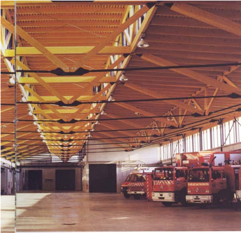
principale autorise une grande finesse des membrures en épicea lamellé-collé.
