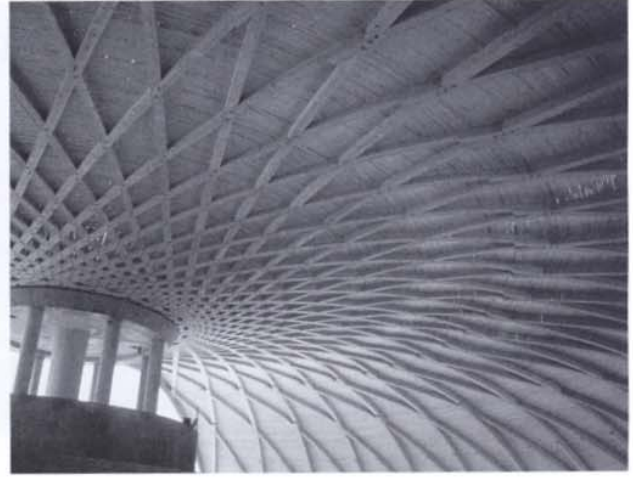
BILD 4: RIPPENSCHALE IN SAINT QUENTIN – DIE AUSGESTALTUNG DES RIPPENGEFLECHTS ERFOLGTE MIT CAD-PROGRAMMEN
