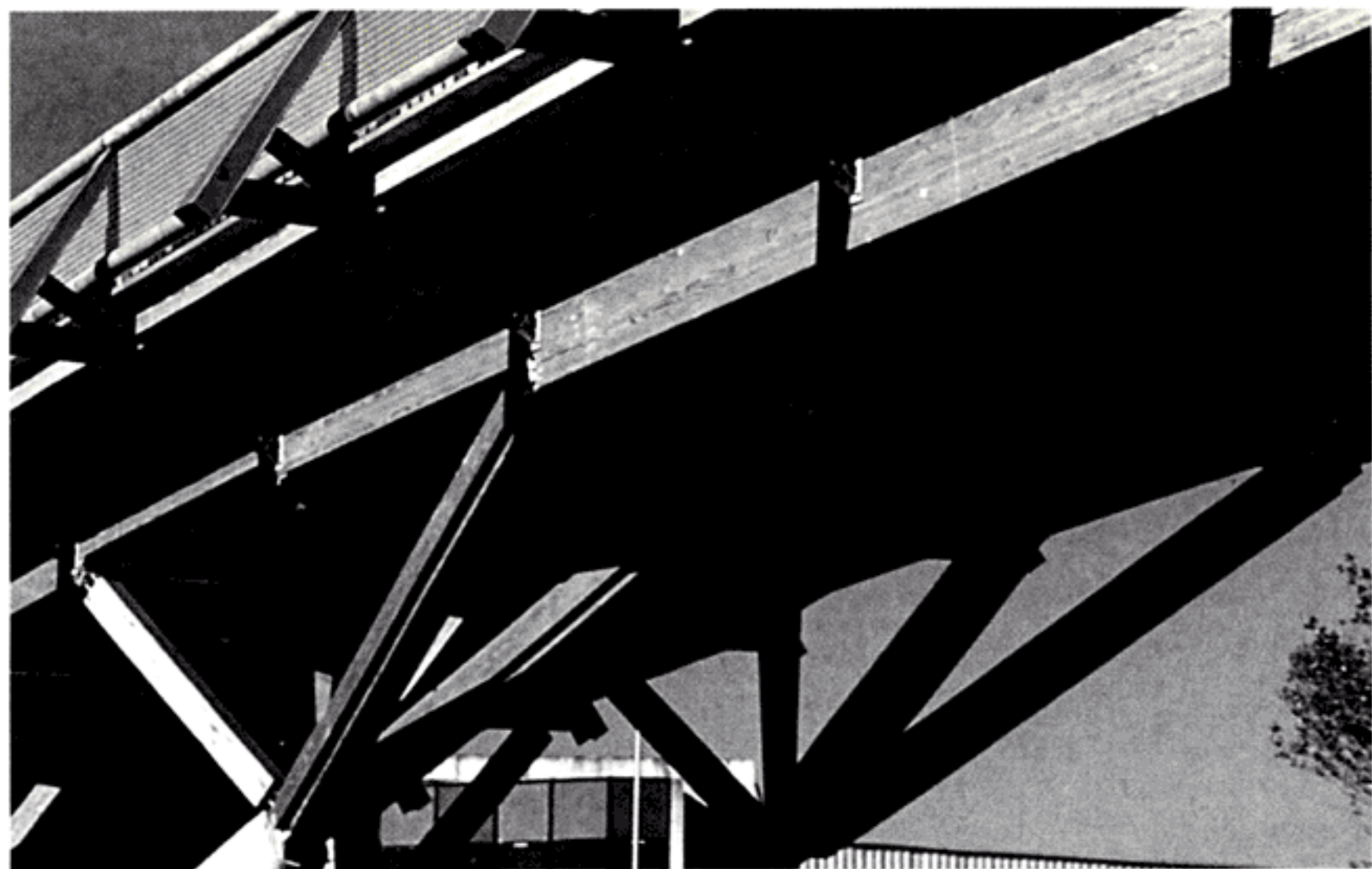
DETAILAUFNAHME DER LEICHTVERKEHRSBRÜCKE IN CREST/FR FOTOS: FLACH
