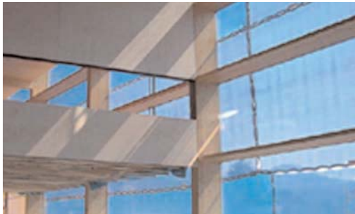
Schulgebäude, Hauptschule Klaus, Vorarlberg
