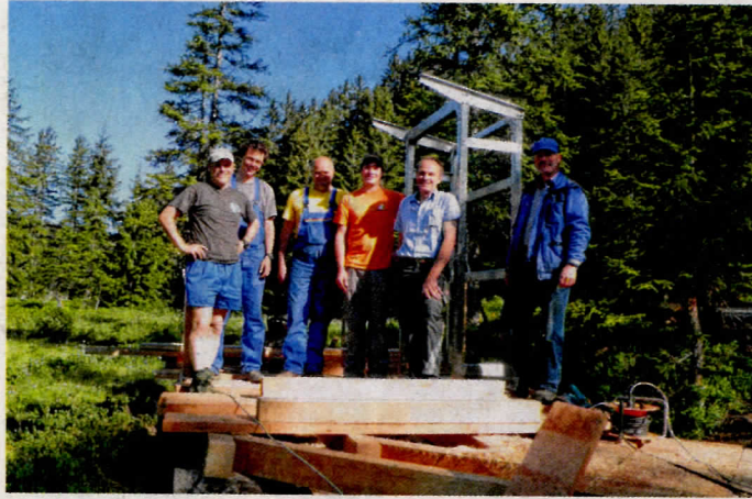
Mitarbeiter der Kristbergbahn und des Bauhofs der Gemeinde Silbertal beim Aufbau einer der interaktiven „Silberpfad“-Stationen. FOTO: VIW
