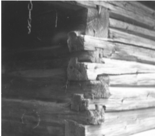
Abb. 9: Schafstall im Blockbau, Balken-Eckverbindung, 1970. Foto: Helmut Meyer.
