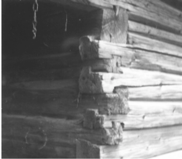
Abb. 9: Schafstall im Blockbau, Balken-Eckverbindung, 1970. Foto: Helmut Meyer.
