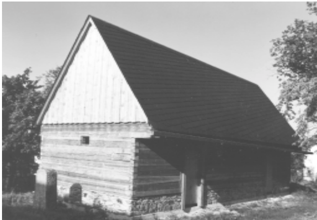
Abb. 12: Schafstall, Gesamtansicht, 2000. Foto: Jörg Hennersdorf.
