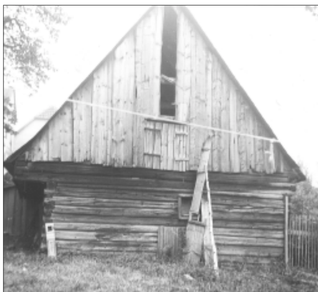
Abb. 8: Schafstall im Blockbau, hinterer Giebel, 1970. Foto: Helmut Meyer.
