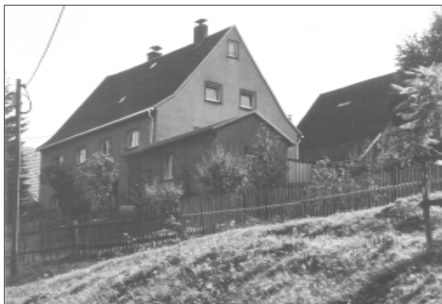
Abb. 18: Ehemaliges Bauernhaus Nr. 39, heute Schulweg 22, Seitenansicht, 2000. Foto: Jörg Hennersdorf.
