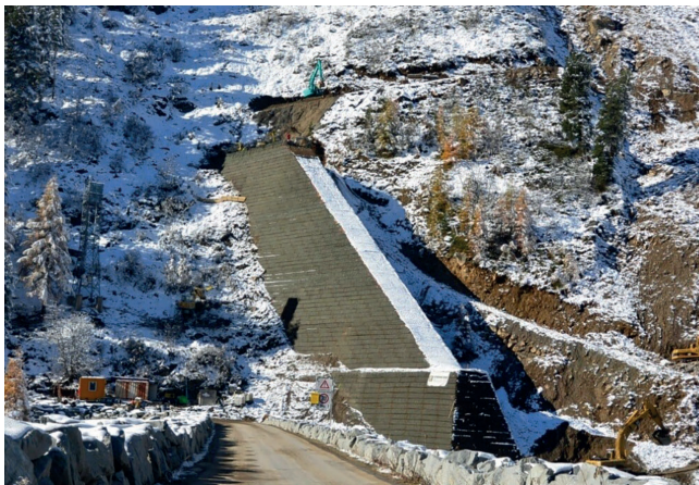
Bild 2. Schutzdamm gegen Felslawinen und Steinschlägen Foto: R. Hofmann Fig. 2. Rock avalanche and rockfall embankment Source: R. Hofmann
