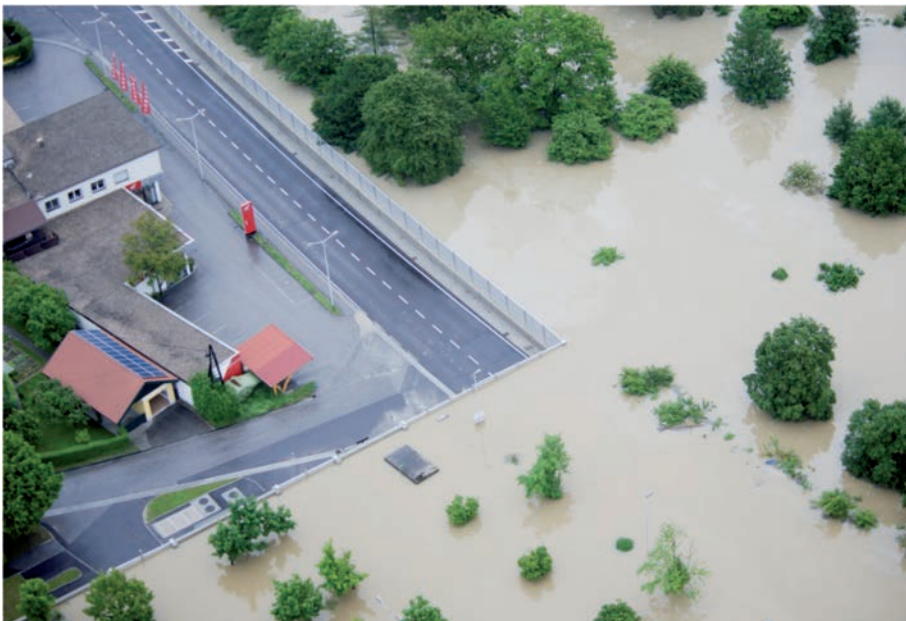
Bild 1 Beispiel eines Hochwasserschutzsystems: Mobile Hochwasserschutzwände an der Donau (Hochwasser 2013). Quelle: Österreichisches Bundesheer
