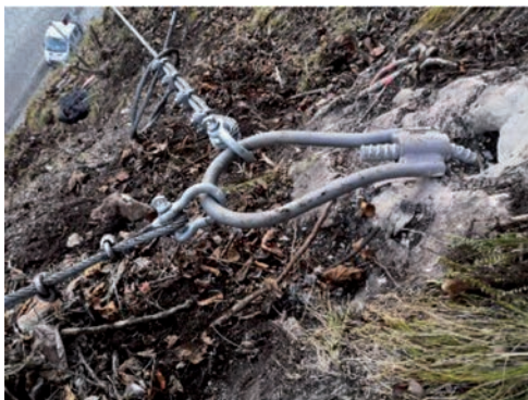
Abbildung 2: Verformtes Tragglied nach Steinschlagtreffer
