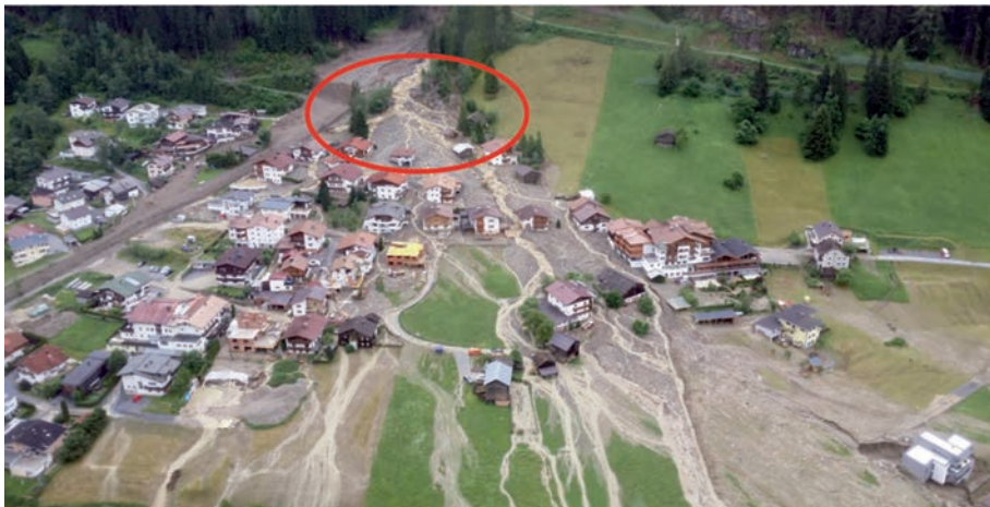
Bild 8 Vermurung einer Siedlung nach einem Sperrenbruch infolge eines Überlastfalls (Katastrophe 2015, Gemeinde See, Tirol) Quelle: (die.wildbach)
