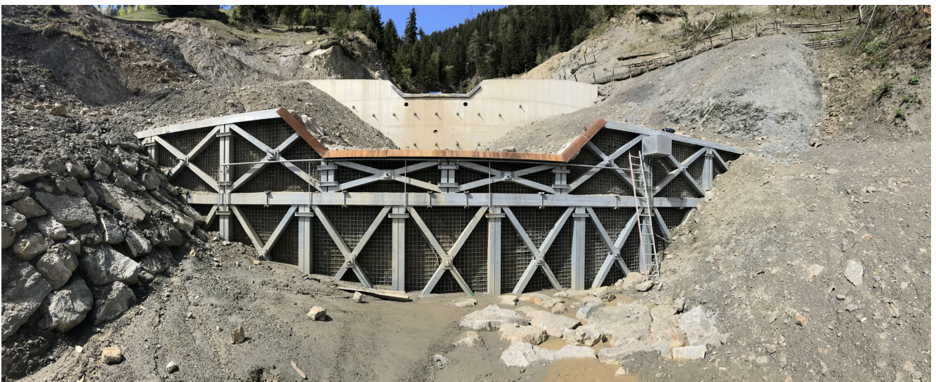
Abbildung 1 - Ansicht auf die Konsolidierungssperren am Toedterbach (Stahl- und Stahlbetonsperre)
