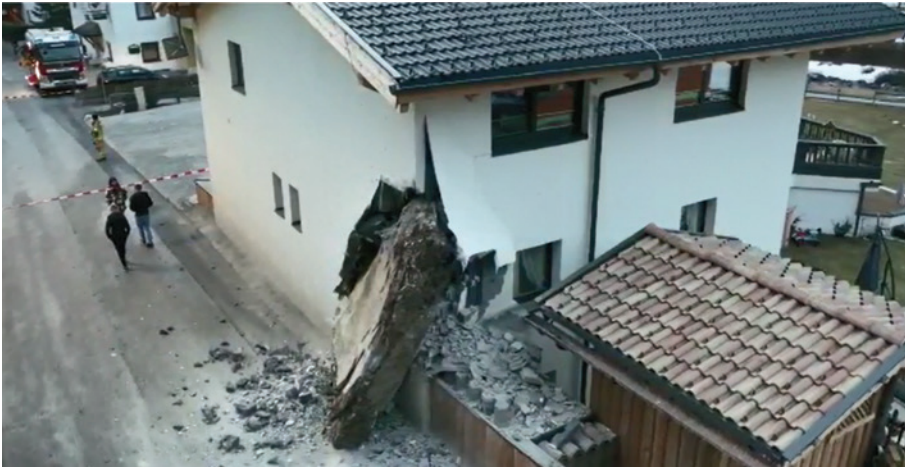
Abbildung 4, Schadblock mit ca. 8 m 3 und beschädigtes Gebäude; © Foto Drohnenbefliegung Feuerwehr Neustift
