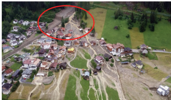
Bild 7, Bauwerksversagen Schallerbach (See, 2015)
