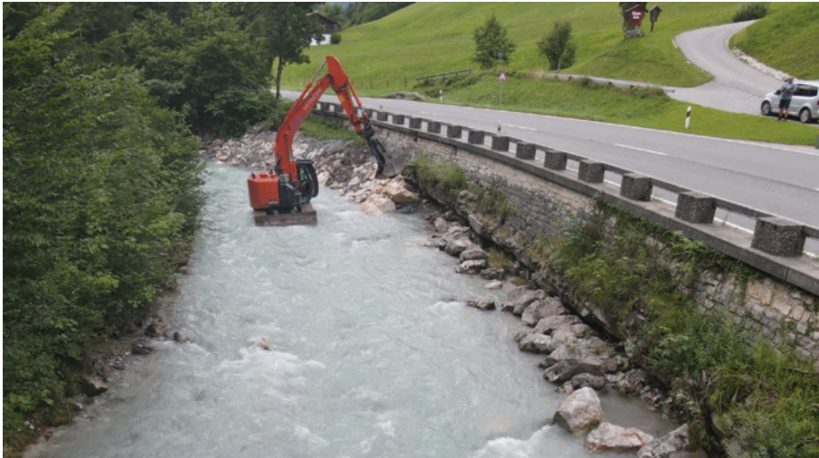
Abb. 6: Sanierung des Kolkshutzes des in Abbildung 5 dargestellten Bereiches im August 2021
