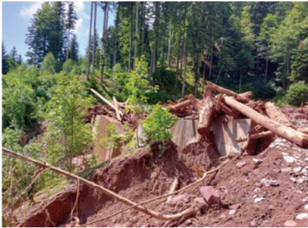
Bilder 5 – 6, Wirkung der Schutzbauten am Badhausbach (li) und Schönachbach (re) – NS-Ereignis August 2021
