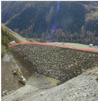
Abbildung 1, Maßnahmen der Wildbachverbauung, Pflasterungen und Konsolidierungssperren
