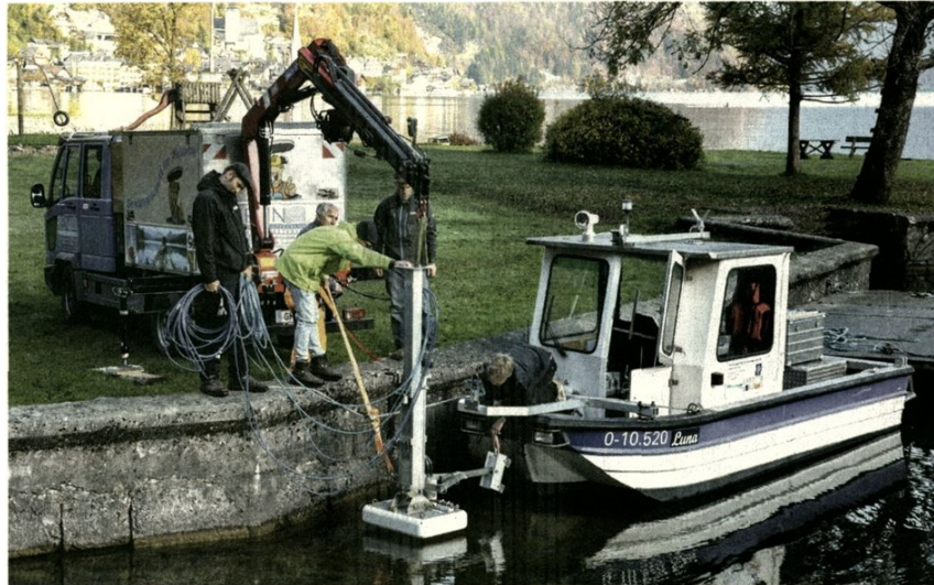
Forscher montieren das hochpräzise Fächerecholot für die Messungen an der „Luna“
