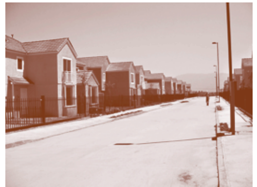
Fig. 6. Tipología constructiva de un barrio de la AUDP “Valle Grande”
