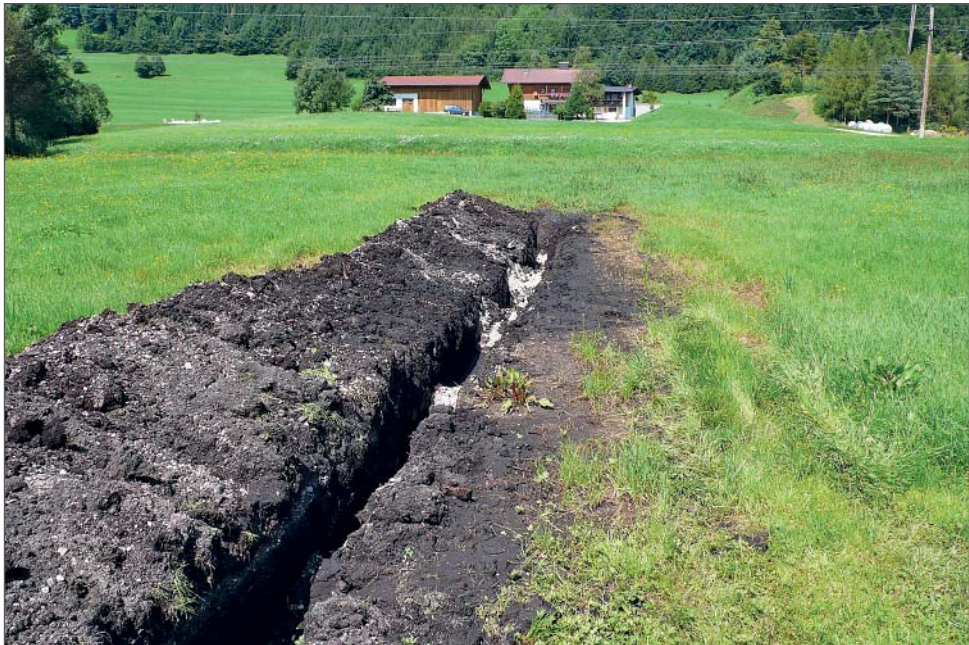
Abb. 1: Der Aushub für die Anlage bzw. Sanierung von Drainagen im Gebiet östlich der Reintaler Seen belegt mit seiner Struktur und dunklen Farbe, dass hier der Untergrund, zumindest im oberen Meter, aus Torf besteht, was an den intensiv genutzten Wiesen kaum zu erkennen ist.
