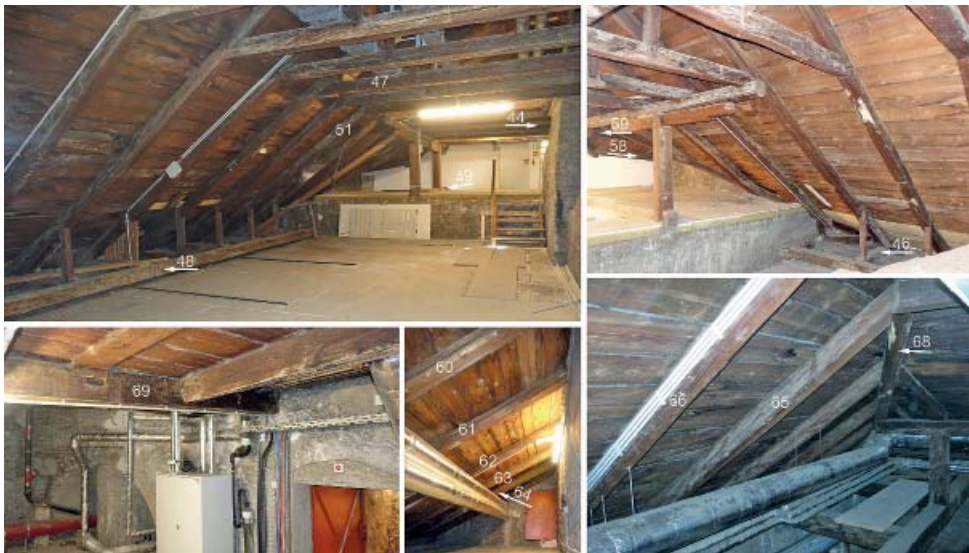
Abb. 2: Teilansichten der untersuchten Dachstuhlbereiche. Analyisierte Hölzer sind mittels Probennummern gekennzeichnet. Oben: Dachstuhl „a“ über Bürotrakt; unten links: Bundtram ihbd-69 unter Pultdach „c“; unten Mitte: Pultdach „c“ über Hofgasse; unten rechts: seitliches Pultdach „c“.
