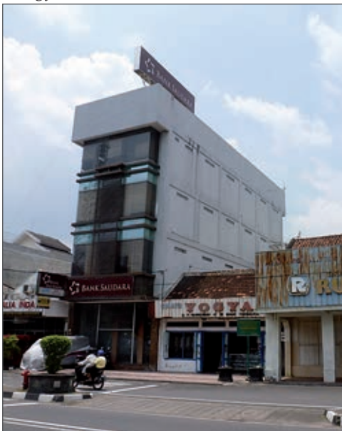
Neubauten an der zentralen Straßenachse (Verlängerung der Jalan Malioboro)
