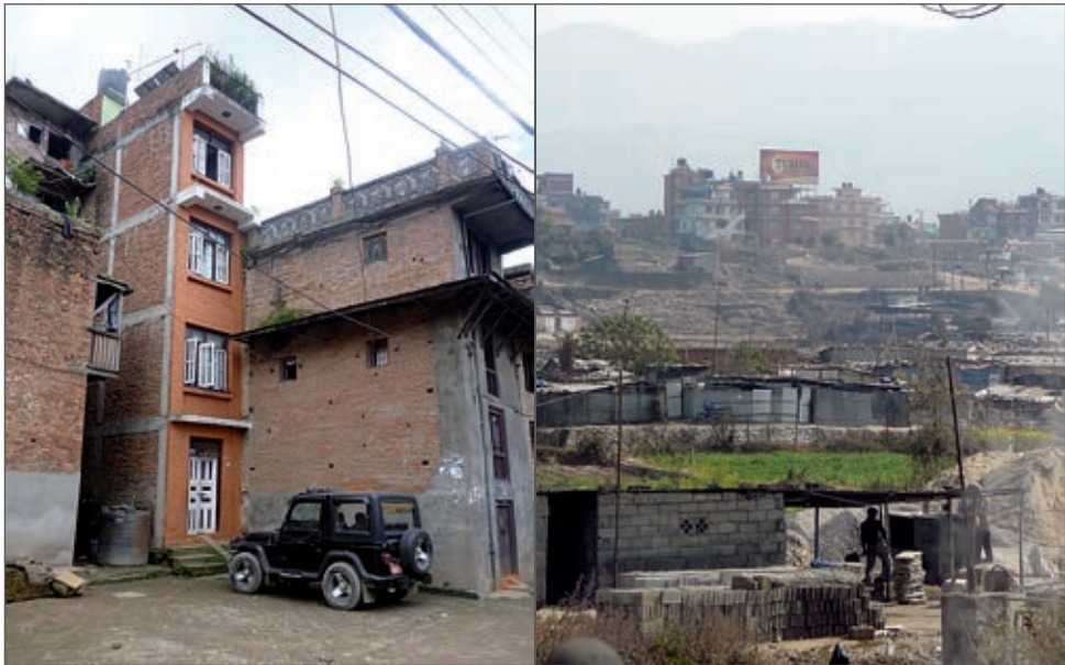
Typisches Beispiel für Neubauten im Kathmandu-Tal, oft ohne Genehmigung errichtet
