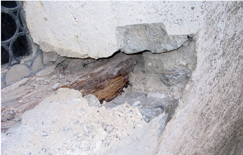
Abb. 1: Der Mauerankerbalken unter dem barocken Fenster in der Nordmauer von St. Leonhard. Am Bohrkern dieses Balkens konnte die Waldkante erfasst und damit das Fälldatum (Herbst/Winter 1130/31 AD) präzise bestimmt werden.
