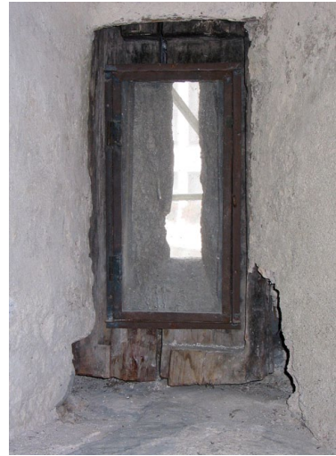
Abb. 3: Das aus einer Lärchenbohle geschnittene Fenster (Probe nleo-28, Endjahr ohne Waldkante 1114 AD) in der nördlichen Chorschultermauer.
