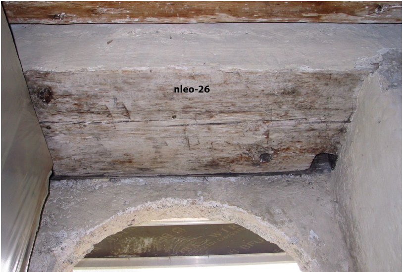
Abb. 2: Die romanische Türsturzhohle aus Lärchenholz (Probe nleo-26, erfasstes Endjahr ohne Waldkante 1091 AD) über der originalen westlichen Eingangstür. Die Ausnehmung in der Ecke der Bohle diente einst als Führung für die Türangel.
