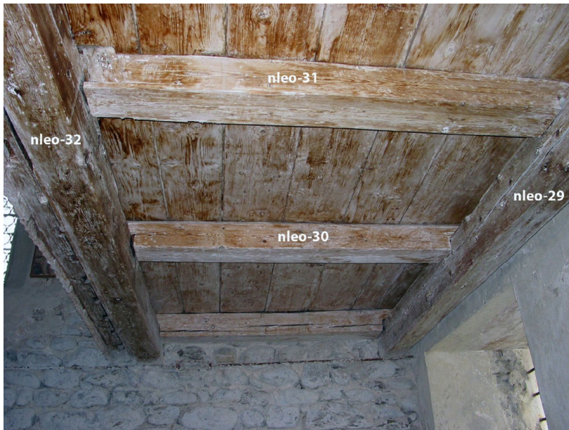
Abb. 5: Unteransicht der Empore an der Westwand der Leonhardskapelle mit Benennung der vier beprobten und analysierten Hölzer (Fälldatum Herbst/Winter 1501/02 AD).
