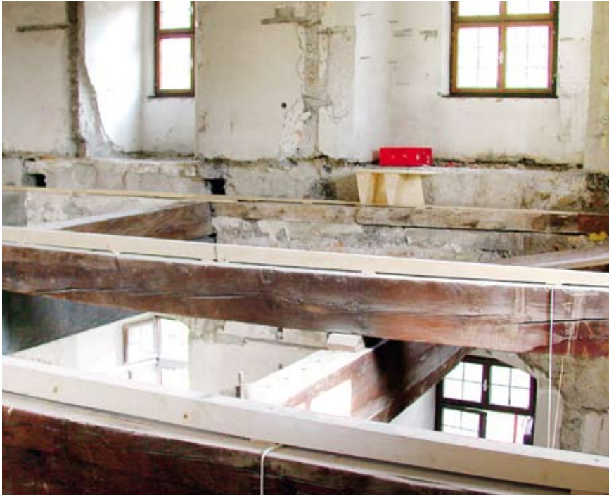
Abb. 2: Aufnahme der Unterzugskonstruktion (Bauphase um 1465) während der Renovierungsmaßnahmen 2006/07 nachdem aufliegende, jüngere Deckenbalken abgenommen worden waren (Blick Richtung SO). Die beiden Längsunterzüge ruhen auf insgesamt drei Querunterzügen und bilden zusammen eine gitterartige Konstruktion. Deutlich erkennbar ist im Bildhintergrund auch ein auf einem Absatz der Südmauer aufliegender Mauerbalken, der zur ersten Palas-Bauphase (um 1440) gehört. Foto: K. Nicolussi.
