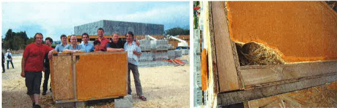
Abbildung: Gips-Strohverputz für eine Stadthalle in Mazan bei Carpentras, F
