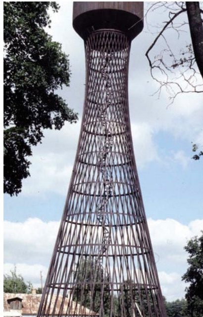
Šuchov hat hyperbolische Wassertürme in verschiedensten Ausführungen geplant, wobei er bei allen Standardisierungsbemühungen stets Form und Proportionen variierte.
