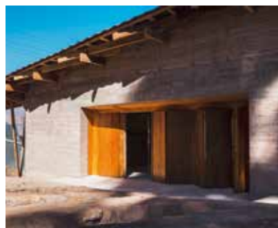
DER ERSTE BAUTEIL des Bildungshauses Wayne Warma wurde 2016 fertiggestellt.
