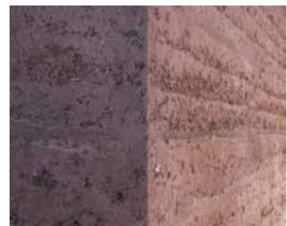
AUSHUB wird Baumaterial: Lehm kommt in Schalungen und wird zu Wänden gestampft.
