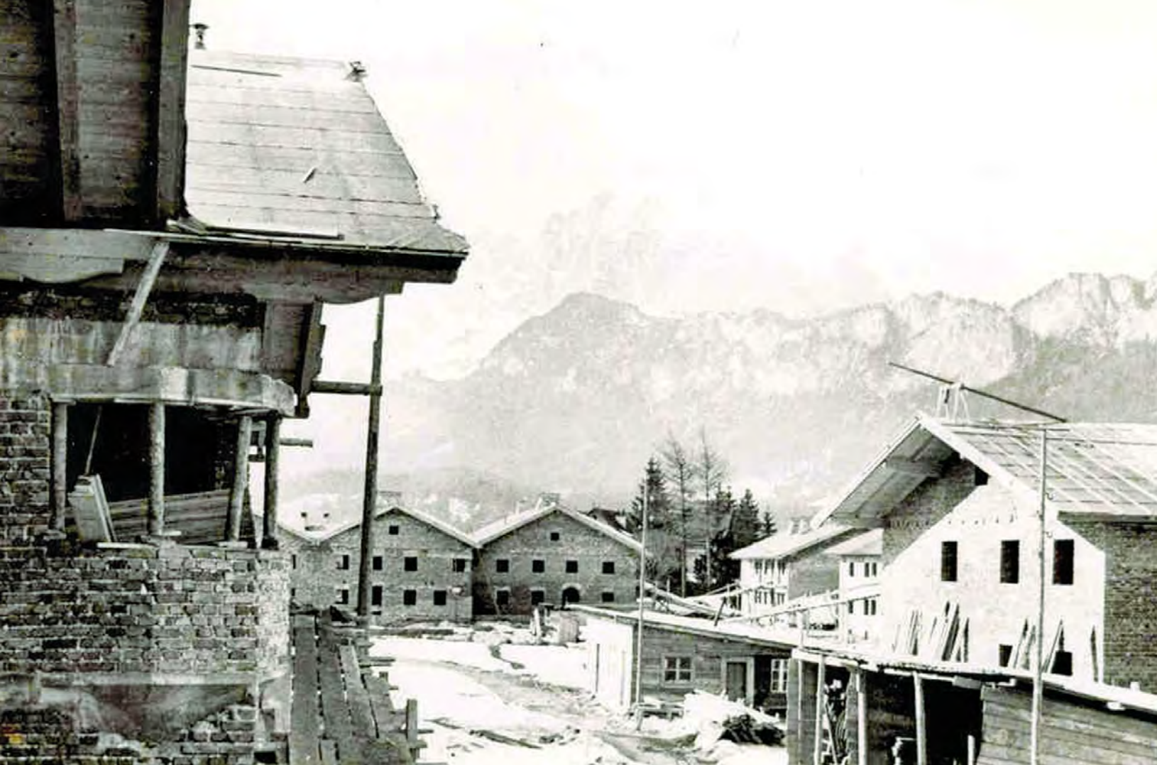
Abb.: Die Siedlung im Rohbau. Foto: Museum St. Johann
