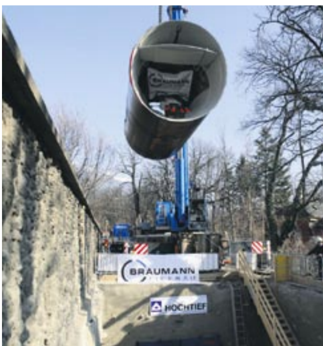
Maulwurf-Maschine. Großes Gerät war notwendig, um die imposante Teilschnittmaschine in die vorbereitete Startgrube zu hieven.
