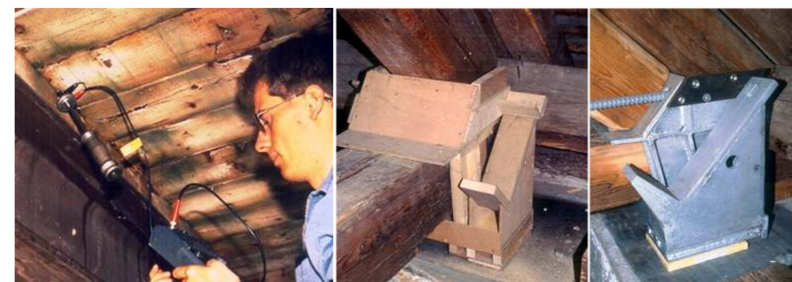
Bestandsaufnahme und Sanierungskonzepte für Holzkonstruktionen
