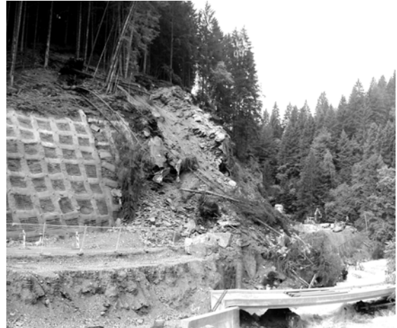
Instabilität eines Hanges
