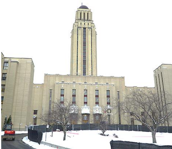
Hauptgebäude der UdeM – Roger-Gaudry
