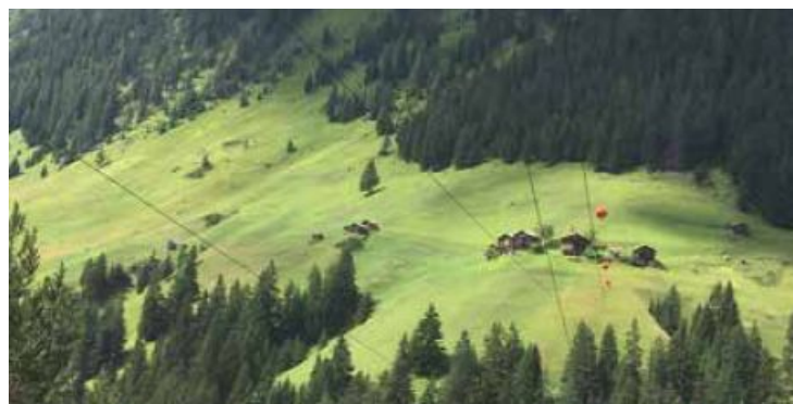
Die Praiswiesen sind nur mit einer Materialseilbahn erschlossen. Der Luftstand beträgt bis zu 200 Meter.
