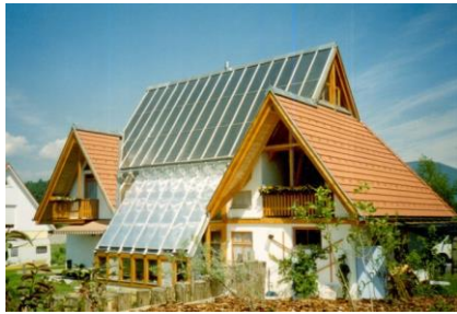
Steiermark EFH Solar Combisystem
