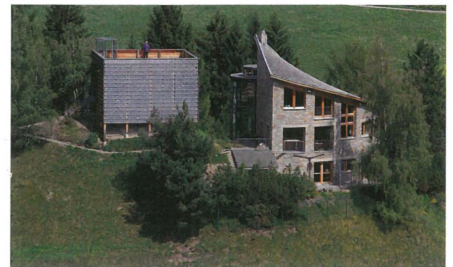
Refugium-Architektur aus heimischer Lärche: Das neue Museum am Zenobichl
