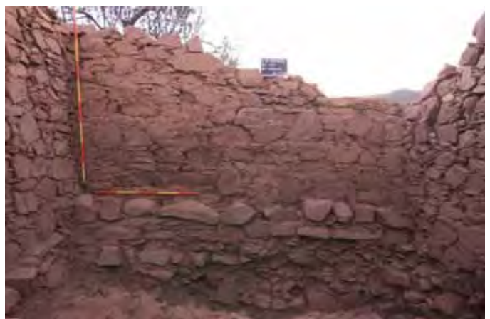
Abb. 2 Ansicht der Ostmauer im zentralen Raum
