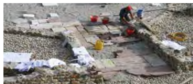
Abb. 3 Verlegung der neuen Bodenplatten
