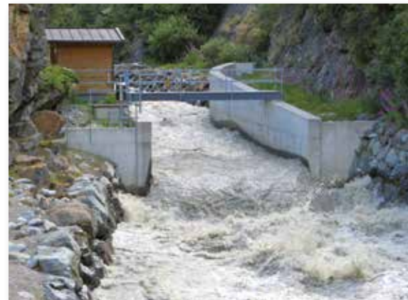
Die Pegelanlage Vent/Rofenache (in Seitental westlich von Obergurgl) im Jahre 2005 mit Pegelhäuschen, Messsteg und betoniertem Gerinne mit Einlauftrumpete im Oberwasser.
