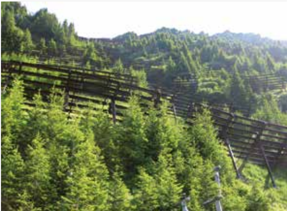
Hochlagenaufforstungen als biologische Verbauungen sind eine unverzichtbare Lawinenschutzmaßnahme. (Foto: L. Weißenbacher)
