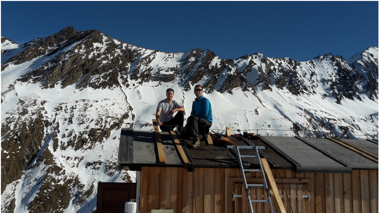
Mitarbeiter der Dienstleistungseinheit für Gebäude und Infrastruktur bei den Ausbesserungsarbeiten am Dach der Forscherhütte auf der Hohen Mut
