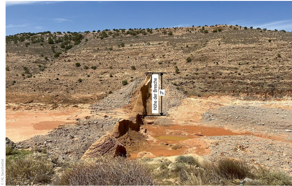
Bild 8: Der Darna-Staudamm nach der Zerstörung
