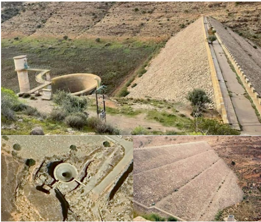
Bild 3: Schachtüberfall, Dammkörper und Krone des Darna-Staudamms vor dem Bruch
