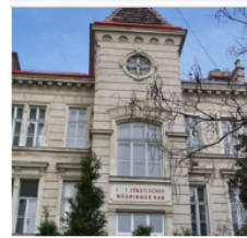
Gefährdet: Währinger Bad (Klostergasse 27)
