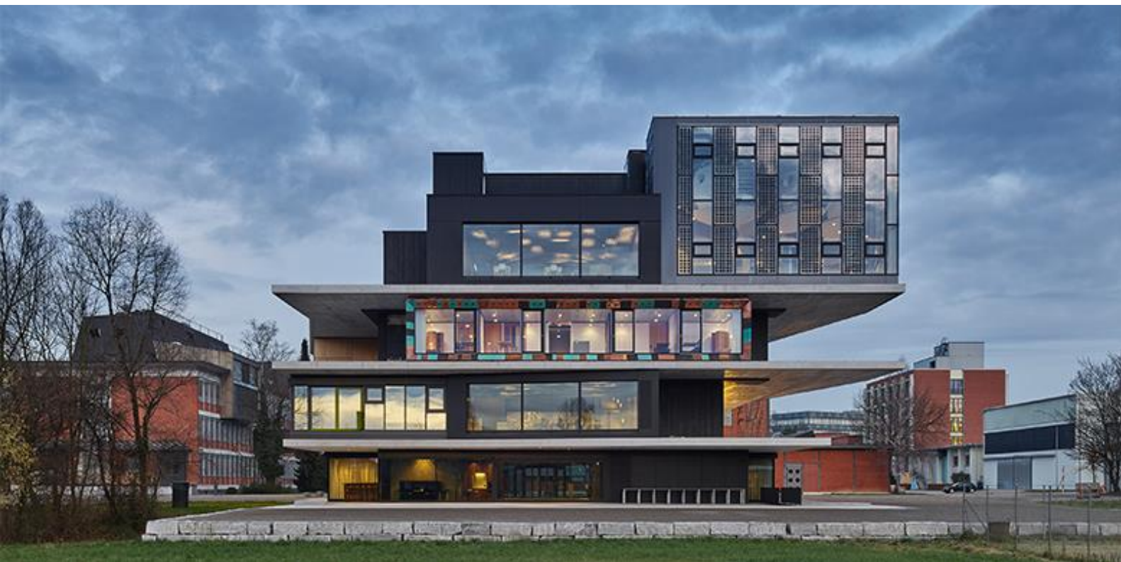
Abb.: Modulares Forschungs- und Innovationsgebäude NEST auf dem Empa-Campus in Dübendorf
